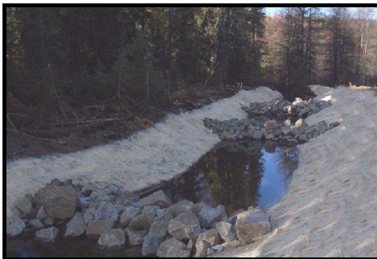
**Figure 3.7** Trappes à sédiments et stabilisation du talus par des matelas de fibres de bois. Tirée du Ministère du Transport, 2008.
