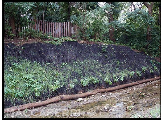
**Figure 3.5** Stabilisation de la pente avec un mur de soutènement constitué d'un remblai renforcé par des géotextiles avec talus végétal.
