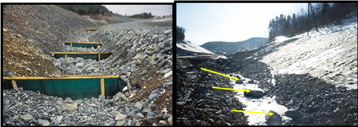
**Figure 3.6** Installation de barrières géotextiles et disposition de pierres pour réduire le débit et favoriser la sédimentation des matières en suspension. Tirée du Ministère du Transport, 2008.
