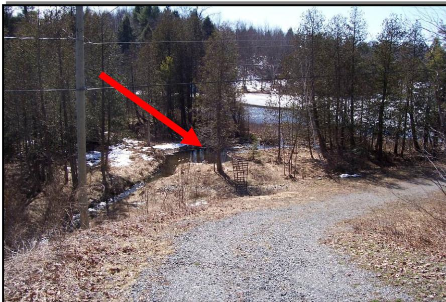
**Figure 3.9** Bassin de sédimentation à la sortie du ruisseau 4 se jetant dans le lac Nick.
