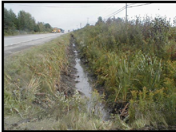
Figure 3.3 Nettoyage d'un fossé par la méthode du tiers inférieur.
