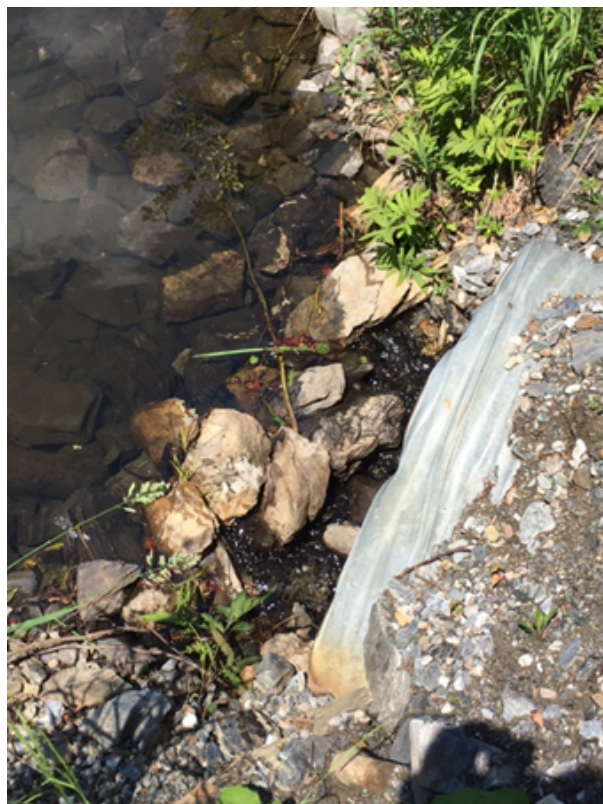
Photo 7. Enrochement du ponceau, 23 juin 2016.
